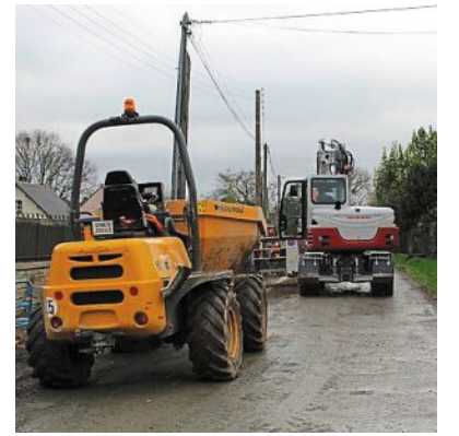
Les travaux devraient se terminer fin janvier. | PHOTO : OUEST-FRANCE
