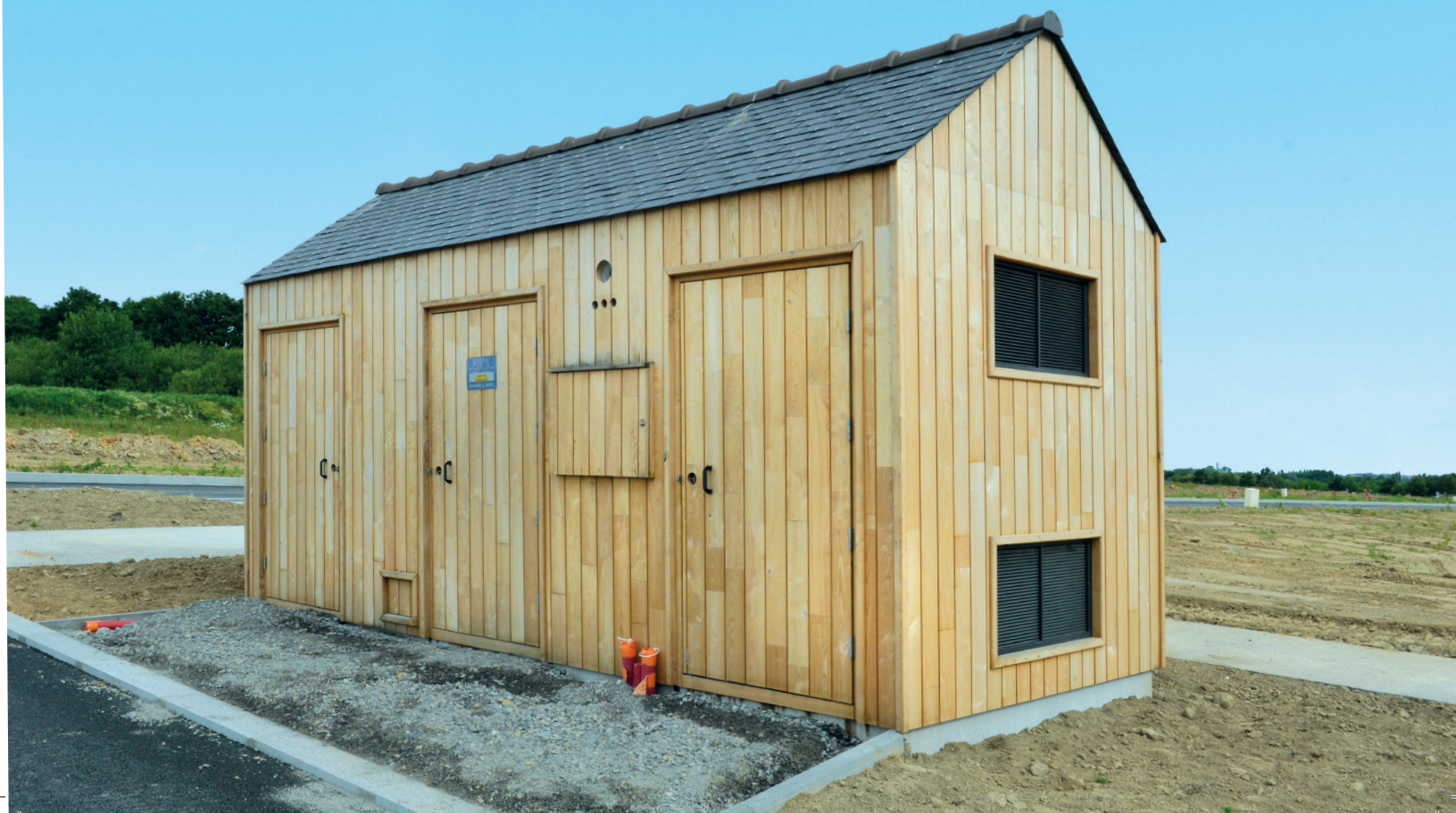
Poste de transformation en habillage bois de la ZAC St-Jouan-Des-Guéréts
