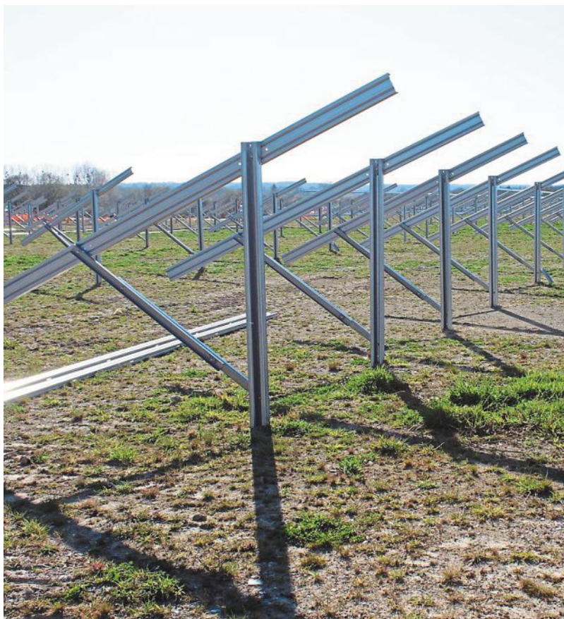
Dès le mois de juin, les panneaux solaires vont être installés sur les fixations, entre Bruz et Pont-Péan. | PHOTO : OUEST-FRANCE
