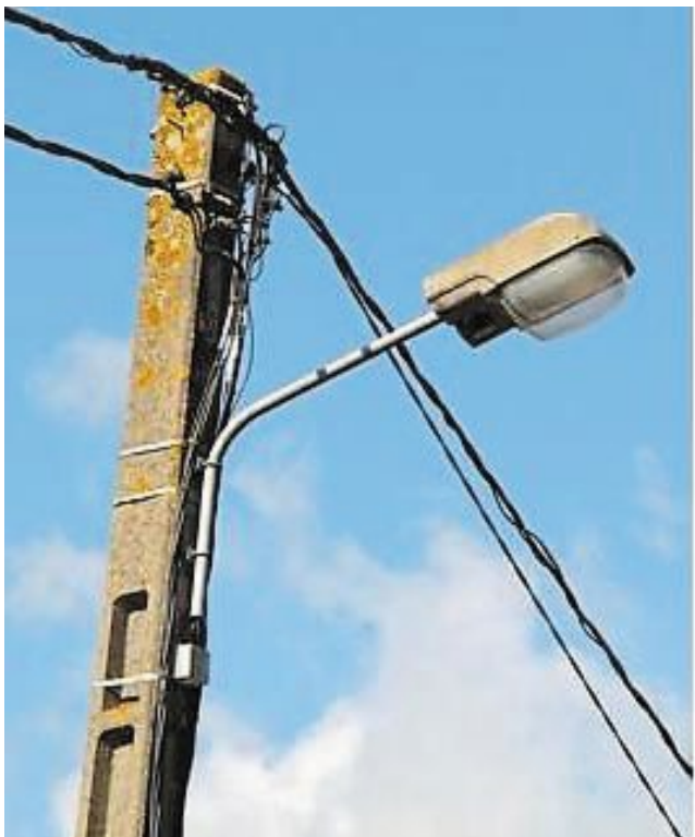
L'éclairage public va être changé pour mettre des ampoules à Led.
