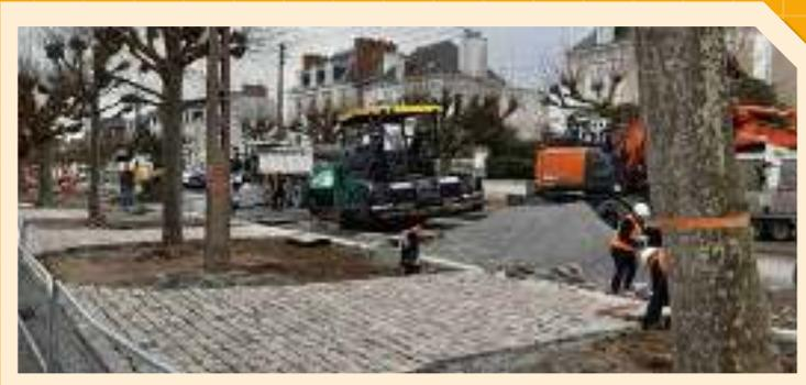
5 Après pose du réseau souterrain, dépose du réseau aérien basse tension en veillant à la protection des arbres
