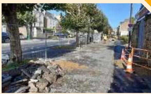
2 Travaux avec maintien de la circulation piétonne et protection des arbres
