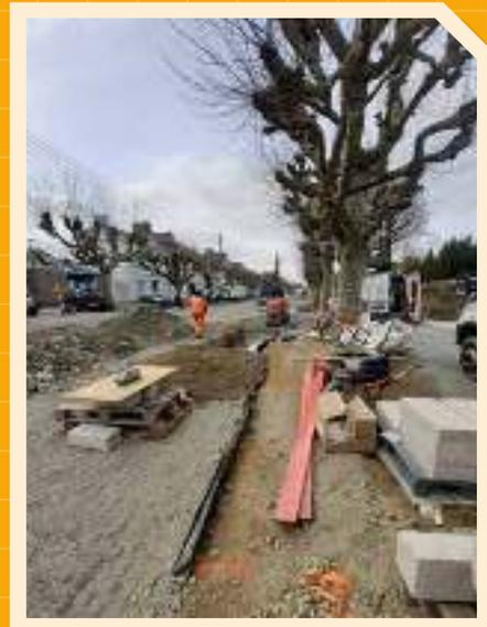
6 Dépose des PBA (support mixte éclairage public et basse tension)
